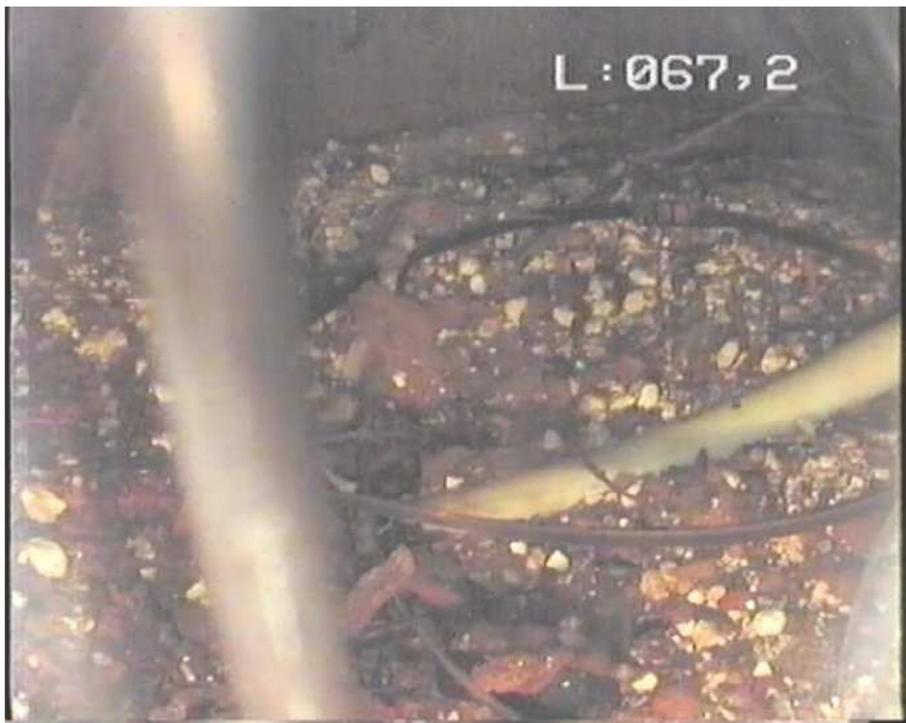
**16- Base de colonne captante avec dépôts et débris**
