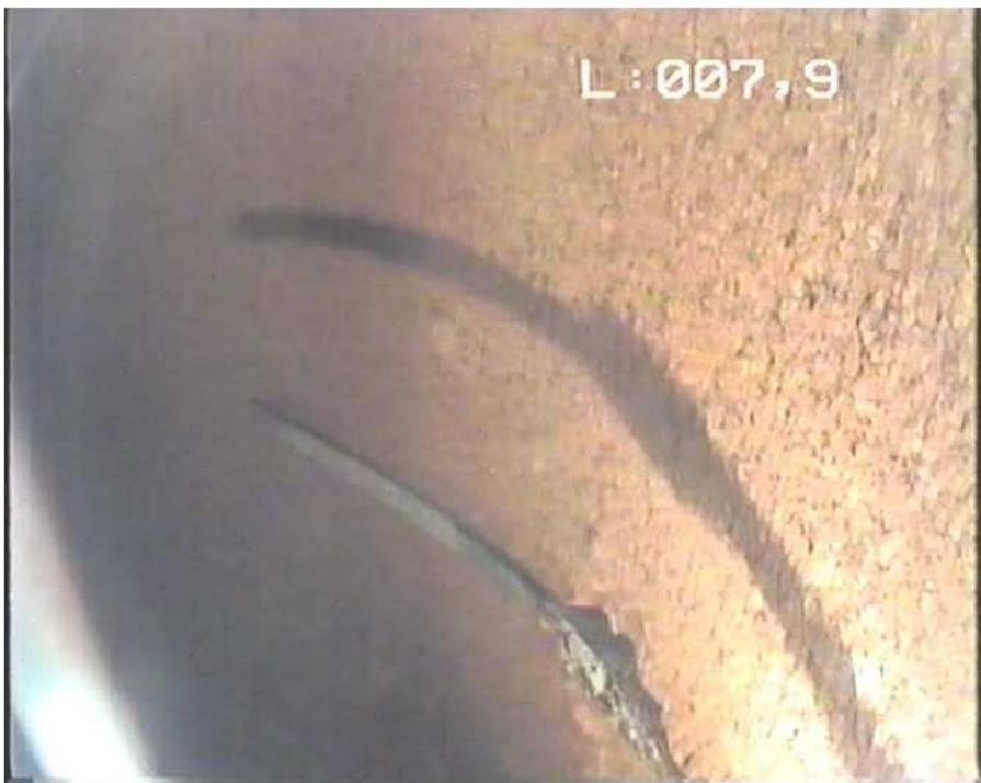
**8- Tubage acier lisse – dépôts minéraux (placage sur le tubage)**
