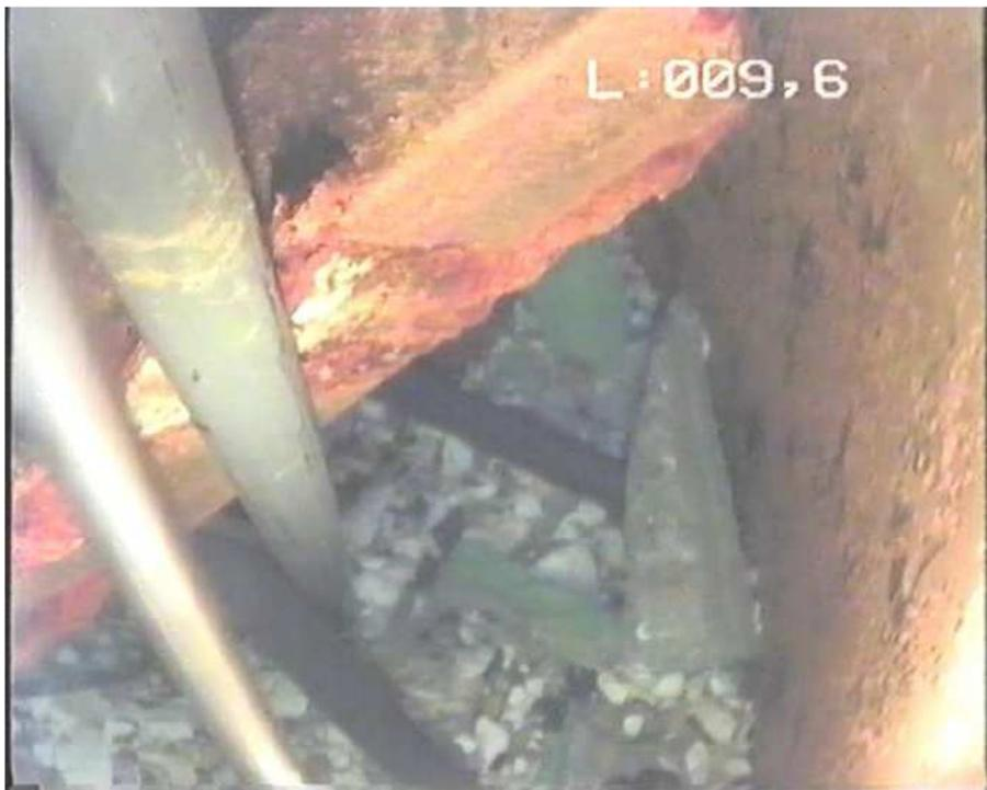
**12- Base d'ouvrage avec dépôts**
