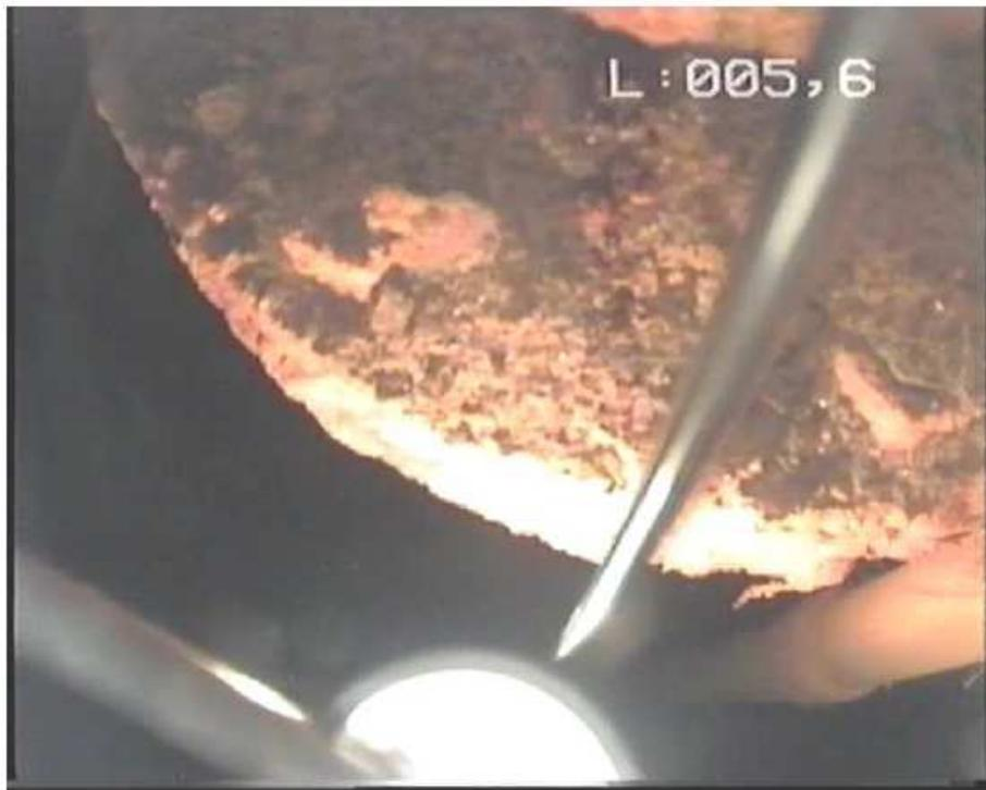
**3- Tubage acier lisse – dépôts minéraux, bride recouverte**
