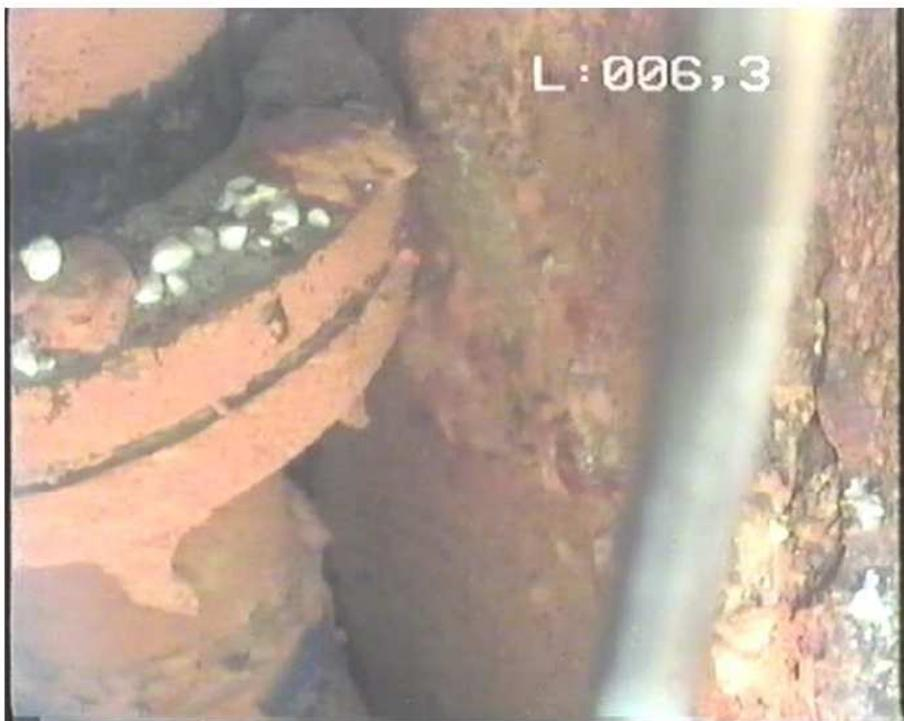
**6- Tubage acier lisse – dépôts importants, bride de colonne d'exhaure**
