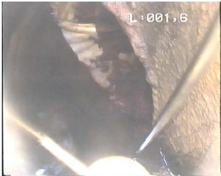
**2- Tubage acier lisse – légers dépôts, niveau statique et buse de trop plein**
