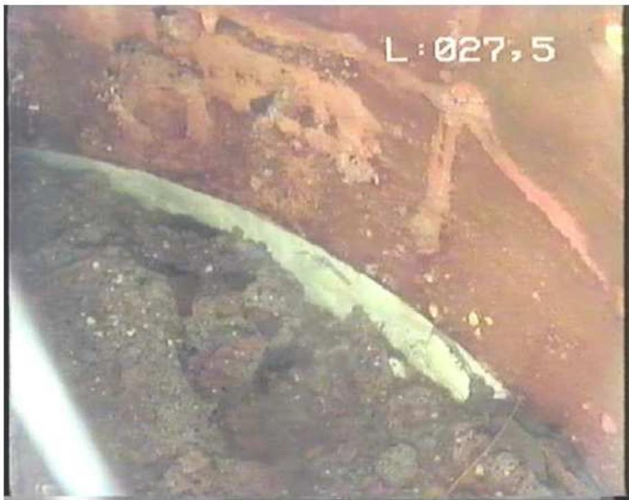
**12- Base d'ouvrage avec dépôts**
