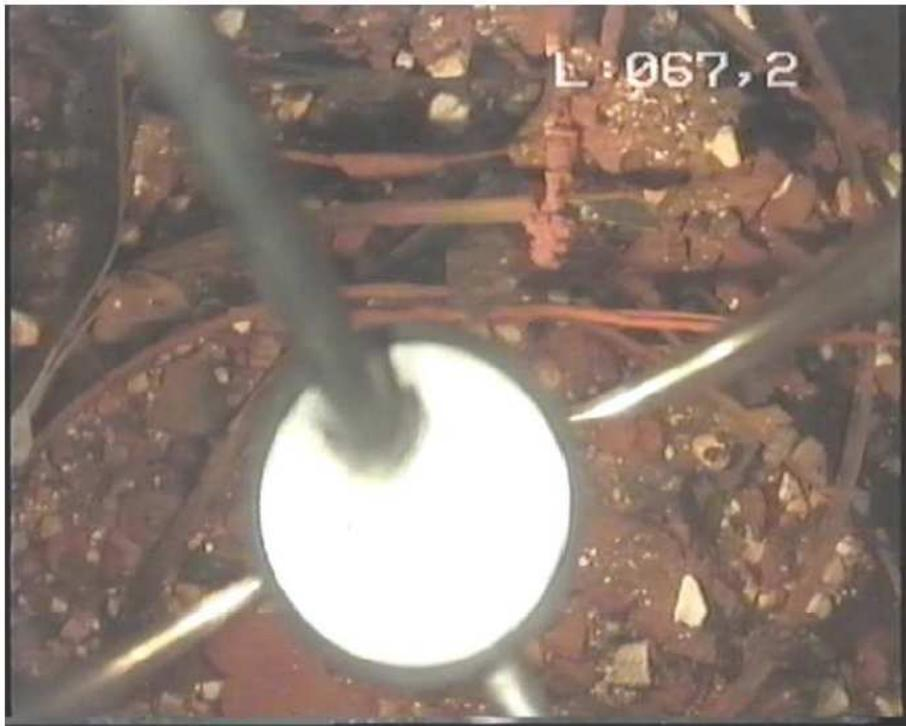
**15- Base de colonne captante avec dépôts et débris**
